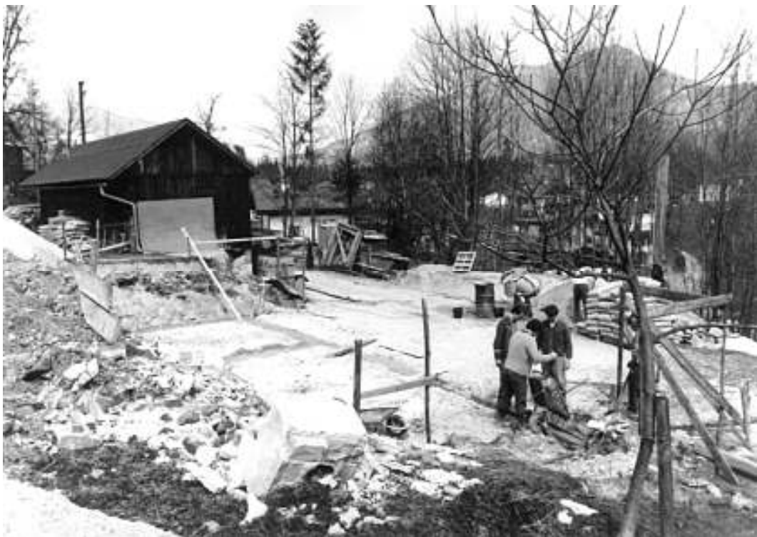
Baubeginn für neues Problokal
